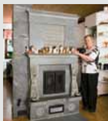
Un poêle à accumulation de chaleur avec four NunnaUuni datant des années 90.
